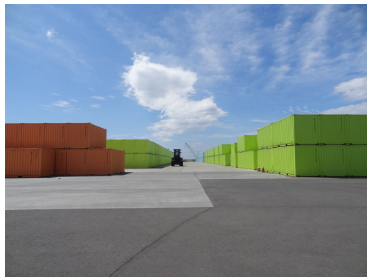
燃料保管場所（コンテナ） での保管状況
